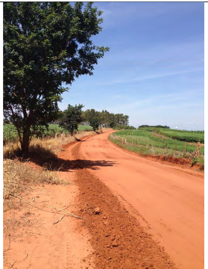
Estrada MCB 134 / Trecho C
