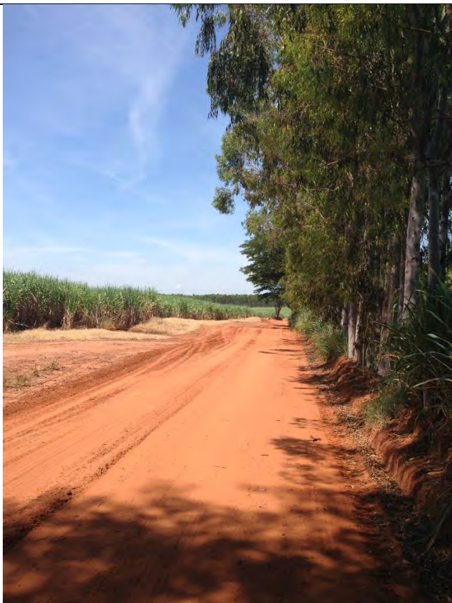
Estrada MCB 134 / Trecho C
