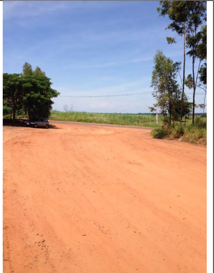
Estrada MCB 134 / Trecho C
