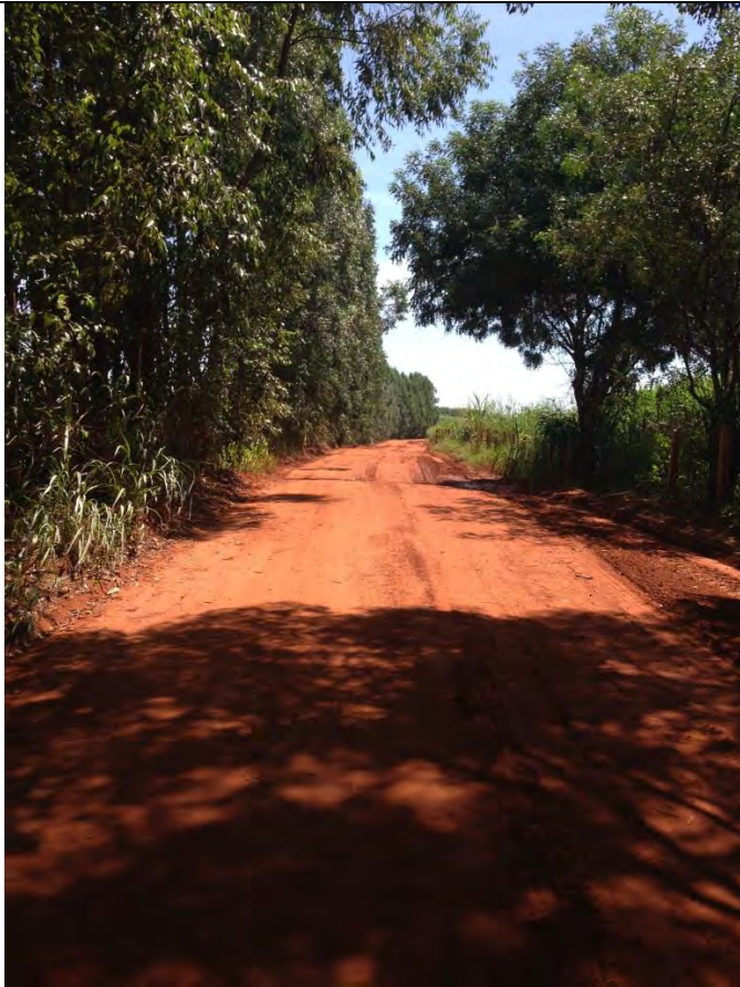
Estrada MCB 134 / Trecho C
