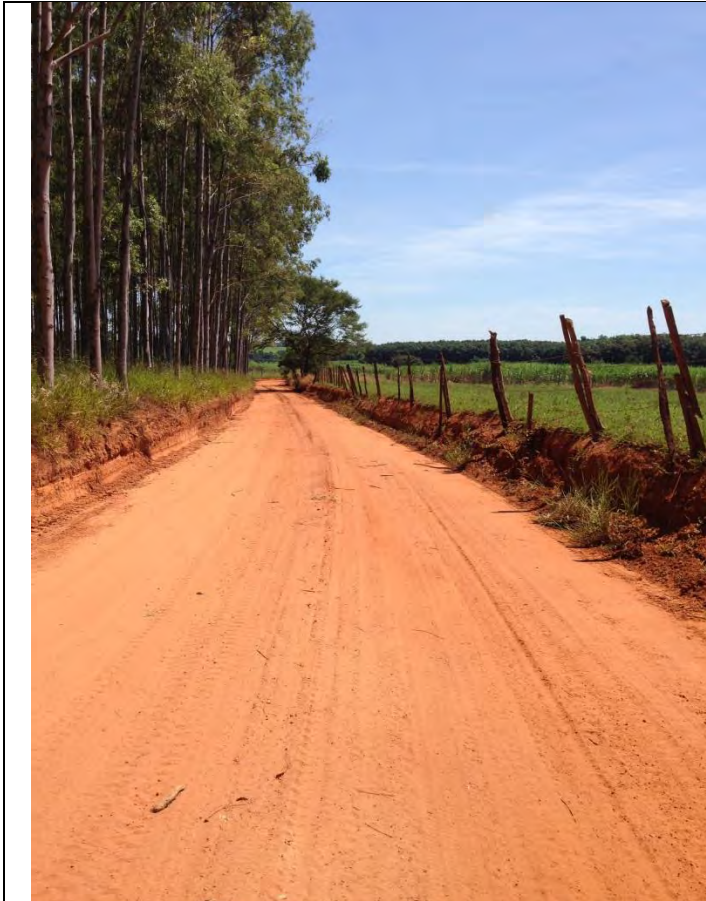
Estrada MCB 134 / Trecho C
