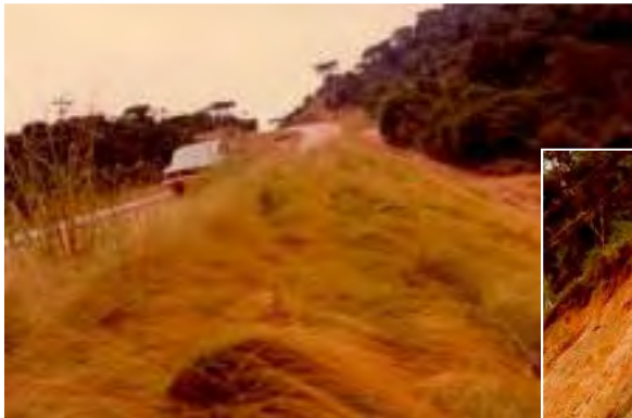
Foto 1: Talude com hidrosemeadura em estágio de crescimento bastante adiantado;
