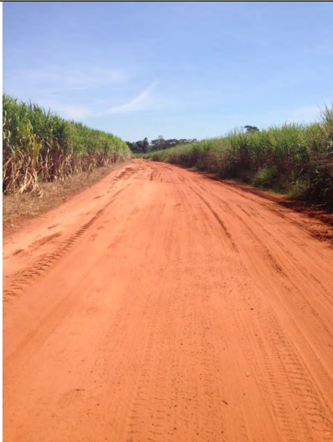
Estrada MCB 134 / Trecho C
