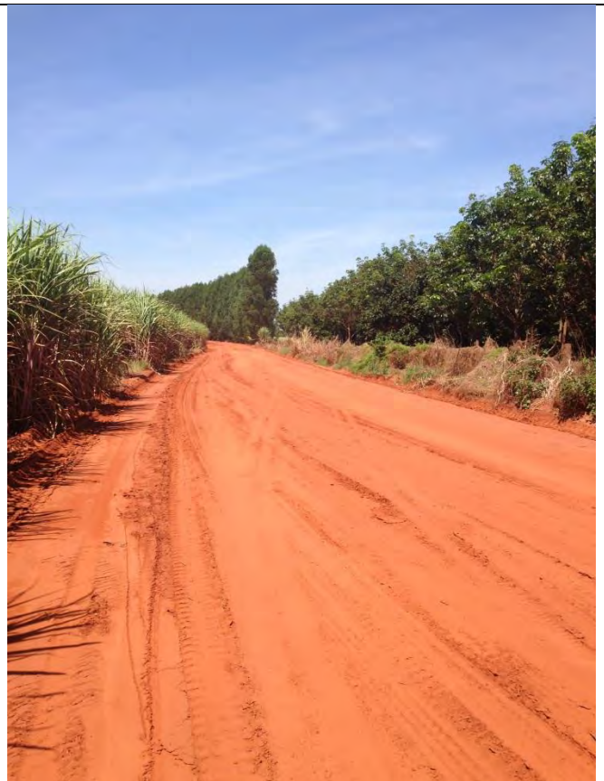
Estrada MCB 134 / Trecho C
