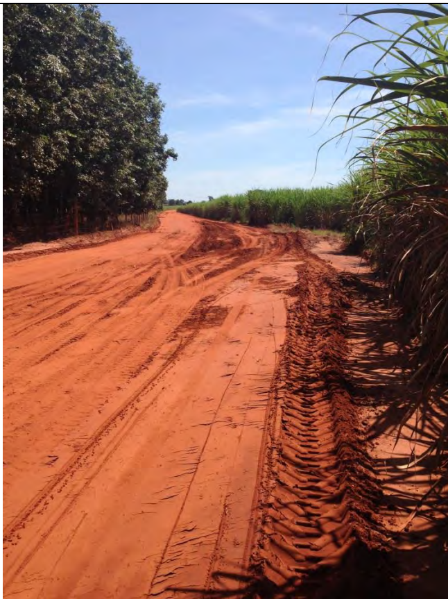
Estrada MCB 134 / Trecho C
