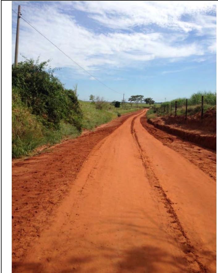
Estrada MCB 134 / Trecho C
