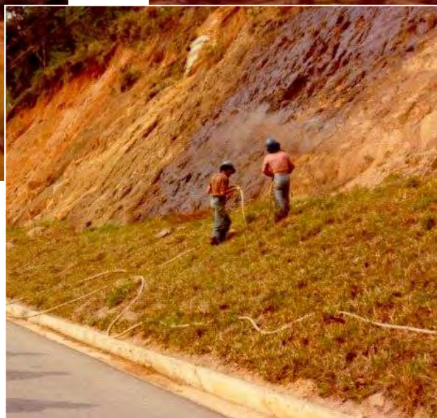
Foto 2: Vista de talude devidamente picoteado e pronto para receber a hidrosemeadura;
